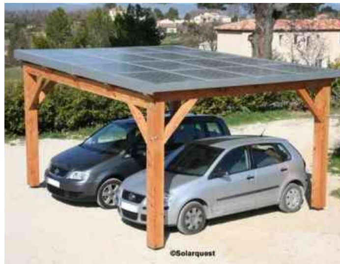
Ombrière photovoltaïque, charpente bois de douglas
