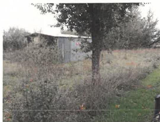
Figure 3: Ruine localisée au sein du périmètre - Kerguillehuic (@DDTM)
