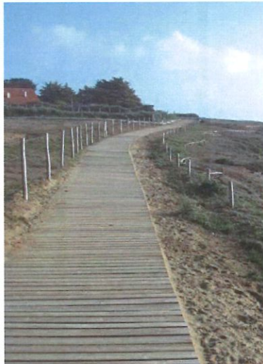
Mise-en-défense 1m et 0.6m
