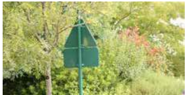
Exemple de signalisation directionnelle routière laquée à l'arrière
