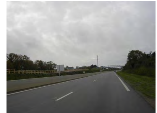
Aménagement piéton pour accéder au Bourg
